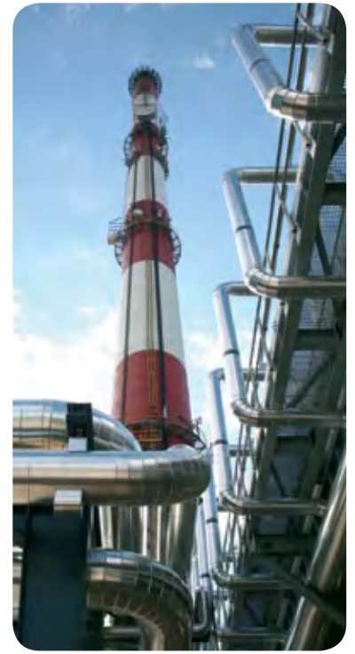
Fortum CHP plant in Częstochowa
