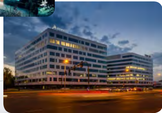
Skanska Biurowiec Kapelanka 42, Kraków
